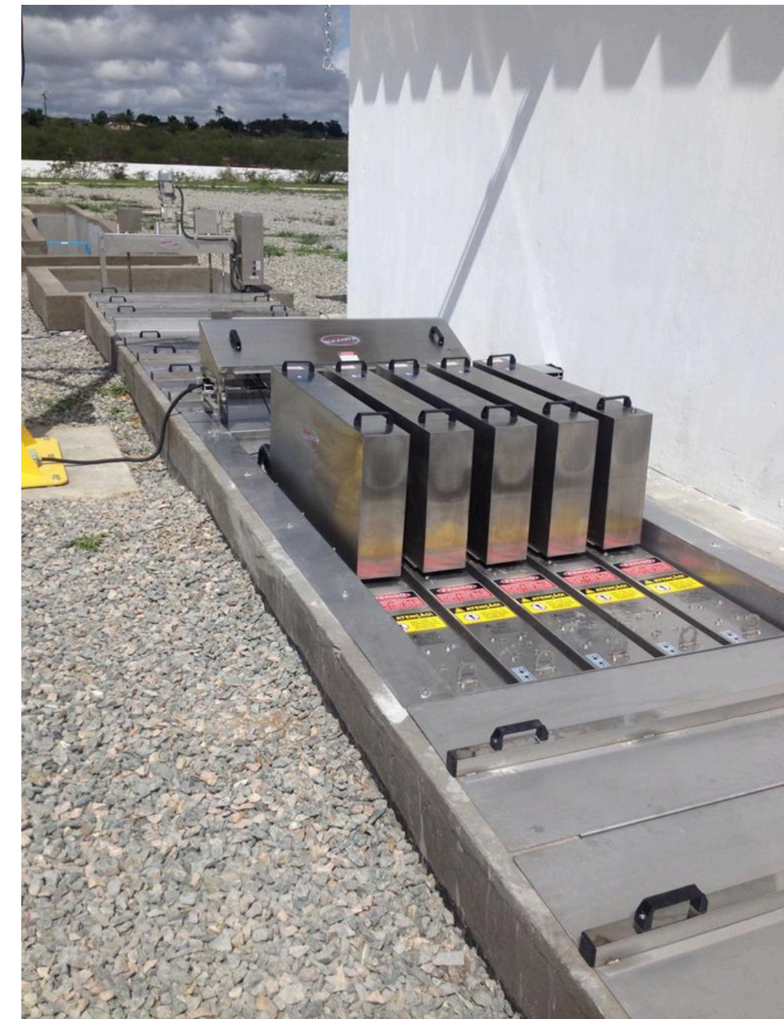
Canal de Alvenaria
